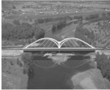
Siltation at modern motorway bridge, Huelva, Spain (Courtesy, Juan Garcia, Centro de Estudios Hidrográficos, Spain)
