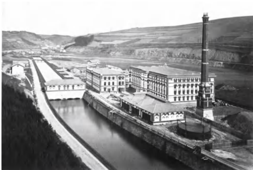
Fig. 15.28 Historical view on SHPP Železný Brod (outlet side) from 1867 ( source Vodní elektrárna Železný Brod, a.s.)
