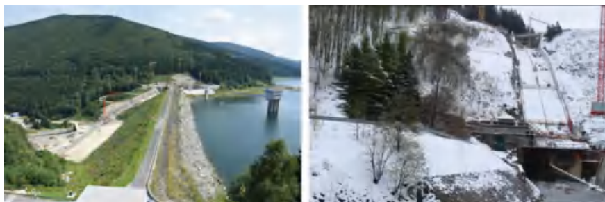
Fig. 11.13 Rekonstrukce vodní nádrže Šance ( https://www.msstavby.cz/ , https://fm.denik.cz/ )
