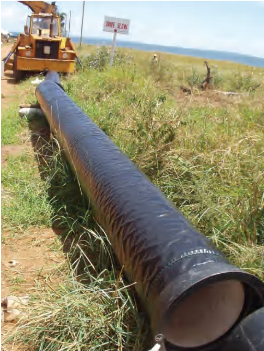
Figure 5.28 A sleeved DI pipe
